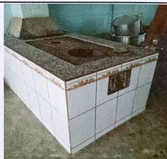
Sustitución de asulejo de plancha de leña en cocina
