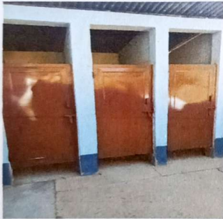
Sustitución de Puertas metálicas en baños
