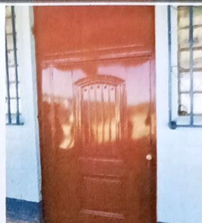
Sustitución de puertas metálicas en aulas de modulo 1
