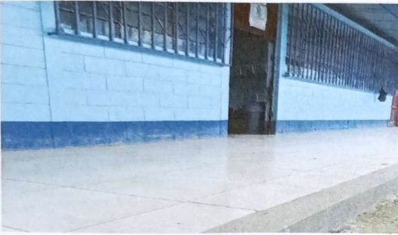
Suministro y aplicación de piso cerámico en pasillo de modulo 1
