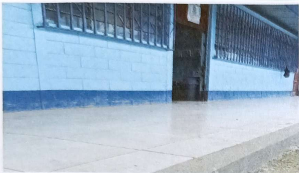
Suministro y aplicación de piso cerámico en pasillo de modulo 1
