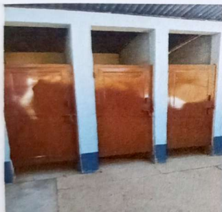
Sustitución de Puertas metalicas en baños
