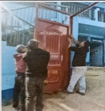
Sustitución de porton metálico
