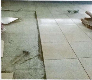
Suministro y aplicación de piso cerámico en pasillo de modulo 1
