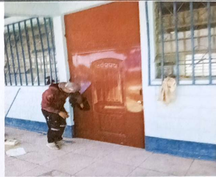
Sustitución de puertas metálicas en aulas de modulo 1
