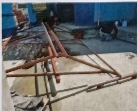
Suatitución de estructura de soporte de madera por metal en entreda de escuela
