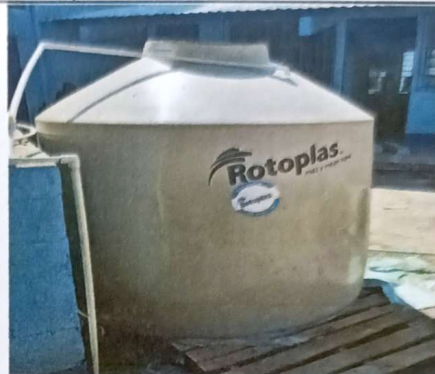
Sustitución de deposito de agua 2500lts.
