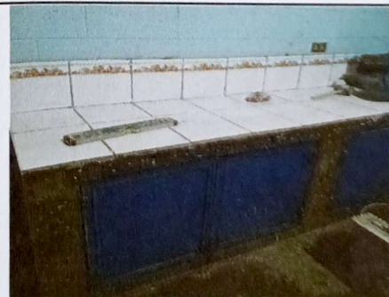
Mantenimiento a gabinetes con azulejos de corados para cocina
