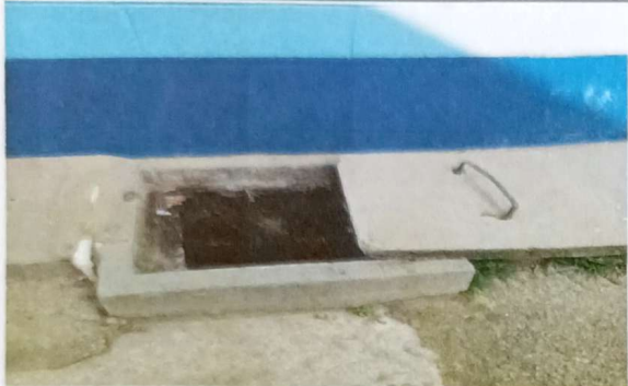
sustitucion de caja de drenaje
