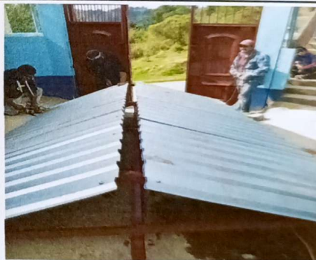
Sustitución de lamina, por lamina troqueleada calibre 25 en entrada de escuela.
