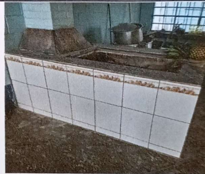
Sustitución de asulejo de plancha de leña en cocina
