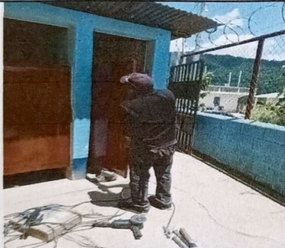
Sustitución de Puertas metalicas en baños
