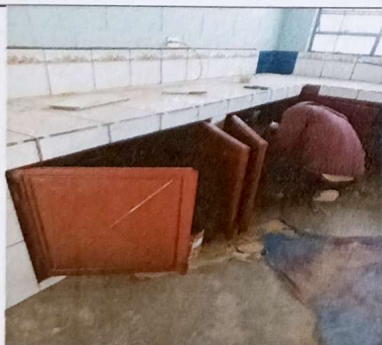
Mantenimiento de 6 puertas metalicas de gabinete en cocina (incluye lijado y pintado)
