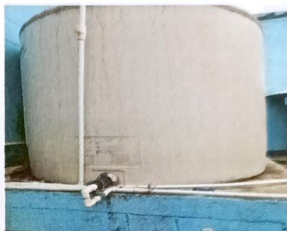
Sustitución de deposito de agua 2500lts.
