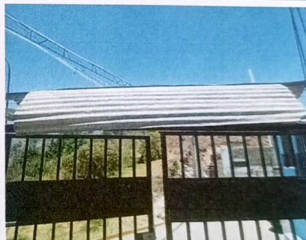
Sustitución de lamina por lamina, por troquela calibre 25 en entrada de escuela
