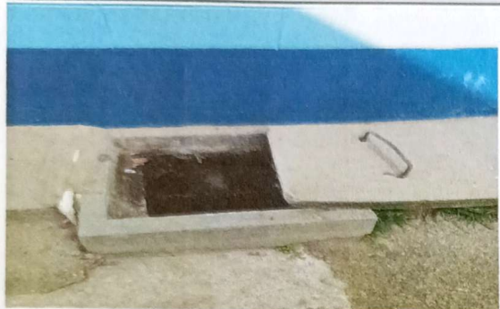
Sustitución de caja para drenaje atrás de la cocina
