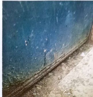
Sustitución de puertas metálicas en aulas de módulo 1
