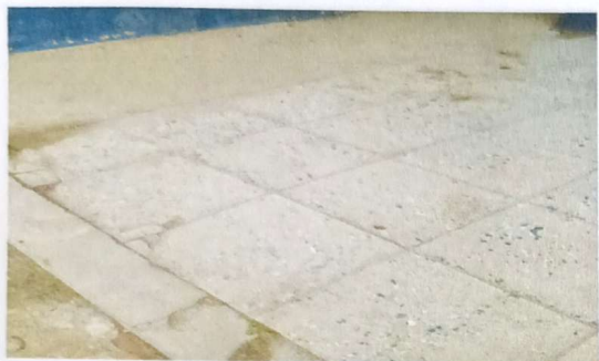
Suministro y aplicación de piso ceramico en pasillo de modulo 1
