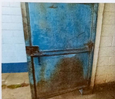
Sustitución de puertas metálicas en baños
