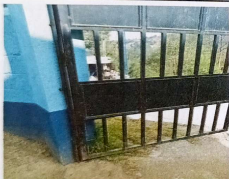
Sustitución de portón metalico 3.25m x 3.00m con tubo cuadrado 2x2 calibre 14 de intupersa en entrada de escuela
