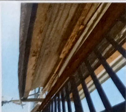
Sustitución de estructura de soporte de madera por metal en entrada de escuela
