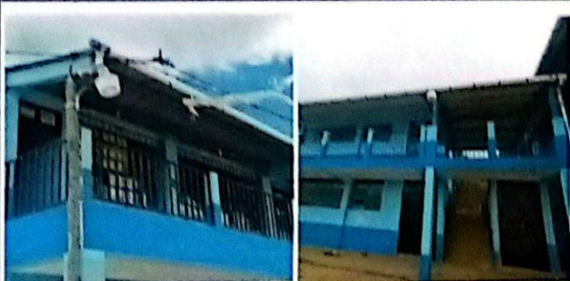
Foto 3: Sustitución de 2 focos e instalación de lámparas tipo canasta en patio del módulo 2 y 3
