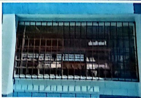
Foto 4: Sustitución de 20 vidrios en ventanas de aula del módulo 2
