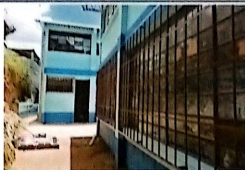
Foto 2: Mantenimiento de ventanas con instalación de 103 m2 de balcones en aulas de los módulos 1, 2 y 3
