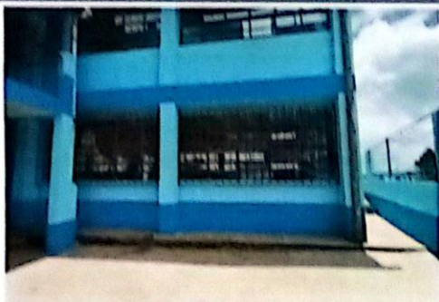
Foto 1: Mantenimiento de ventanas con instalación de 103 m2 de balcones en aulas de los módulos 1, 2 y 3
