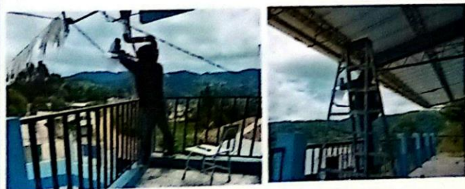
Foto 3: Sustitución de 2 focos e instalación de lámparas tipo canasta en patio del módulo 2 y 3
