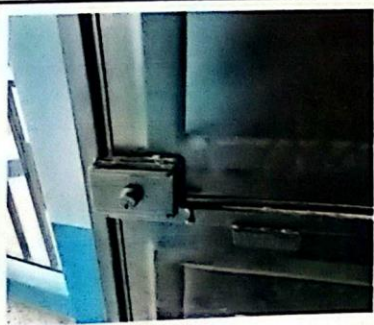
Foto 5: Sustitución de 3 chapas marca YALE en puertas del módulo 2 y 3 y sustitución de 3 tomacorrientes del módulo 2
