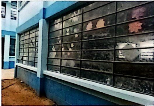
Foto 2: Mantenimiento de ventanas con instalación de 103 m2 de balcones en aulas de los módulos 1, 2 y 3
