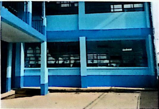
Foto1: Mantenimiento de ventanas con instalación de 103 m2 de balcones en aulas de los módulos 1, 2 y 3
