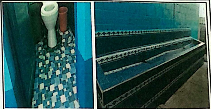
Foto 2: Sustitución de concreto por cerámico 30 m2 en baños y lavamanos azulejo. Finalizado 100%
