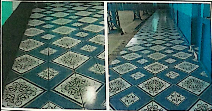
Foto1: Sustitución de piso concreto a piso cerámico 310 m2 dentro de aulas y corredor módulo 3. Finalizado 100%
