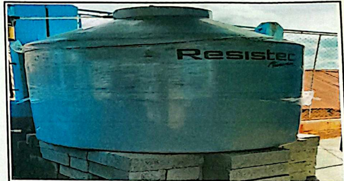
Foto 4: Sustitución de Rotoplas de 750 lts por Rotoplas de 2,500 lts módulo 2. 100%
