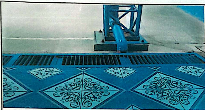
Foto 3: Mantenimiento lijado y aplicación de pintura en 23 regillas tragante de agua pluvial alrededor de la cancha. Finalizado 100%
