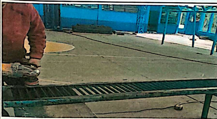
Foto 3: Mantenimiento lijado y aplicación de pintura en 23 rejillas tragante de agua pluvial alrededor de la cancha
