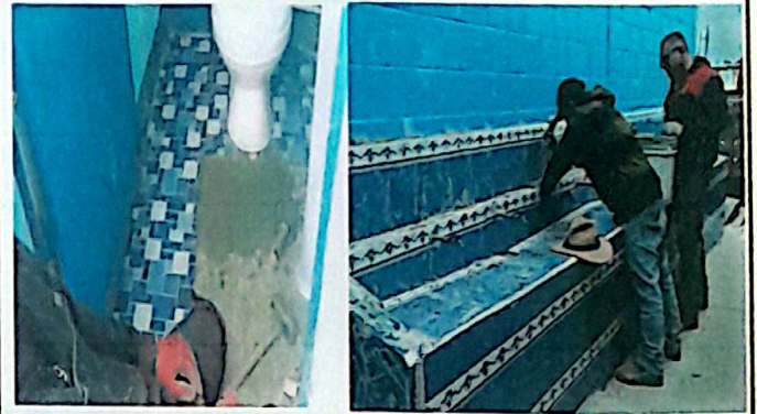
Foto 2: Sustitución de concreto por cerámico 30 m2 en baños y lavamano
