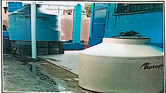
Foto 4: Sustitución de Rotoplas de 750 lts por Rotoplas de 2,500 lts módulo 2
