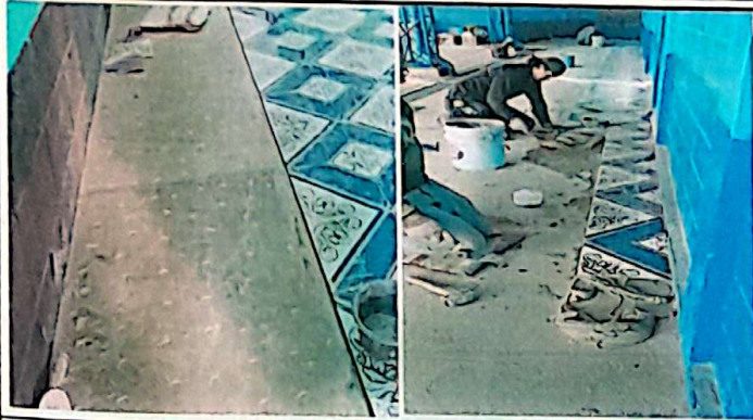
Foto 1 : Sustitución de piso concreto a piso cerámico 310 m2 dentro de aulas y corredor módulo 3
