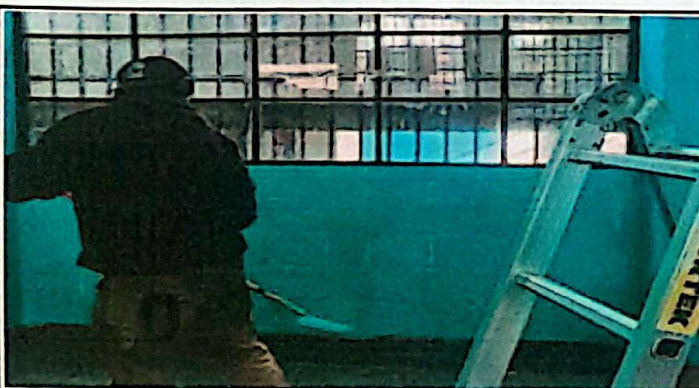
Foto 5: Mantenimiento y aplicación de 80 m2 de pintura latex en el interior de la Dirección módulo 1
