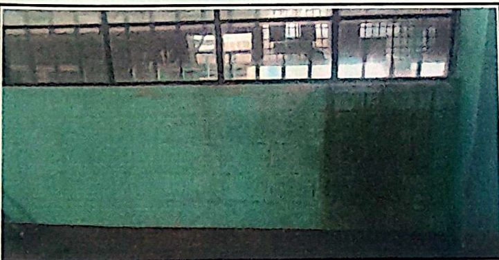
Foto 5: Mantenimiento y aplicación de 80 m2 de pintura latex en el interior de la Dirección módulo 1.
