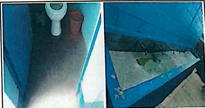
Foto 2: Sustrucción de concreto por cerámico 30 m2 en baños y lavamanos.
