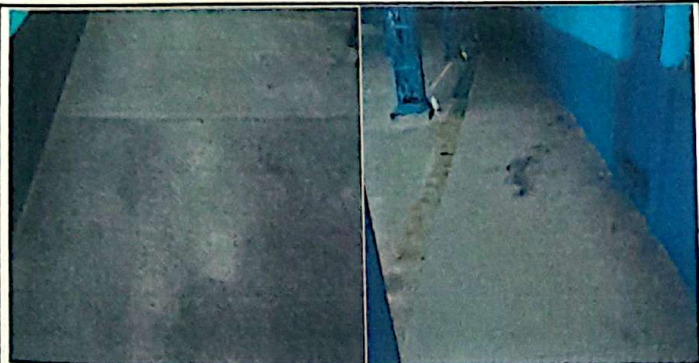
Foto 1: Sustrucción de piso concreto a cerámico 310 m2 en aulas y corredor módulo 3
