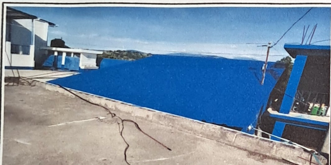
Foto 3: Mantenimiento a 60 m2 de techo de lámina con pintura anticorrosiva (incluye limpieza y lijado previo) en área de Cocina Escolar.
