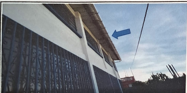
Foto 5: Sustitución de 14 mts. de Canal de Agua Pluvial de 3" y accesorios PVC en Módulo 1.
