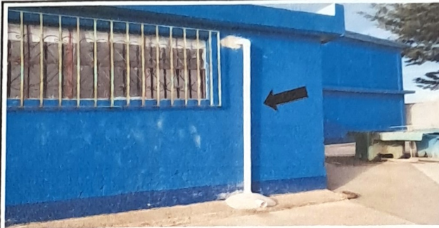
Foto 2: Sustitución de bajadas de agua pluvial con tubo de 2 1/2" en aulas de módulo 2.
