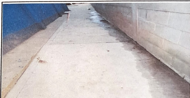
Foto 4: Reparación de 110 m2 de plancha de concreto en pasillos posteriores de Módulo 1, módulo 3, área de cocina y área de servicios sanitarios.
