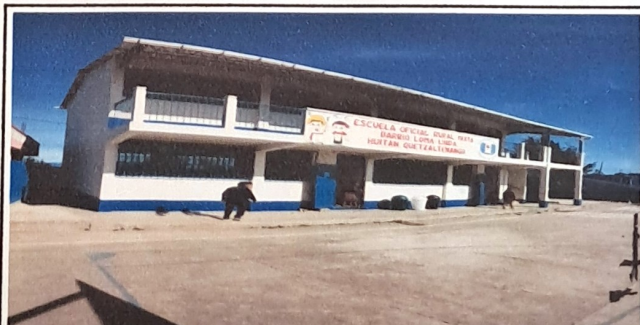
Foto 6: Suministro y aplicación de 350 m2 de pintura exterior e interior, en Módulo 1, latex color blanco hueso (incluye limpieza, resane mínimo y aplicación).
