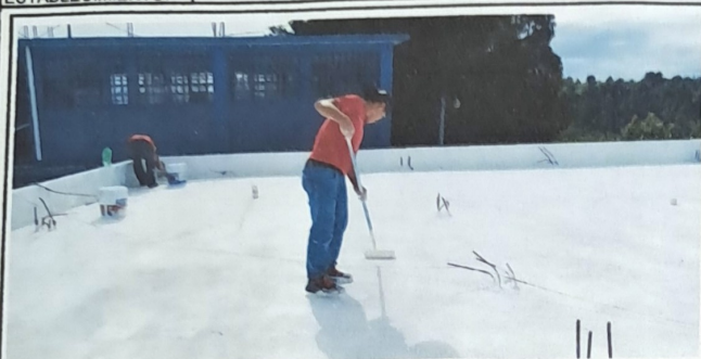
Foto 1: Mantenimiento correctivo de 198 m2 de losa con impermeabilizante acrílico de 6 años en aulas de módulo 2.
