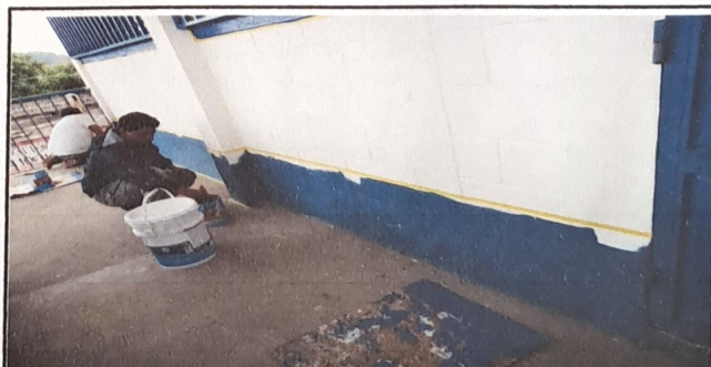
Foto 6: Suministro y aplicación de 350 m2 de pintura exterior e interior, en Módulo 1, latex color blanco hueso ( incluye limpieza, resane mínimo y aplicación)
