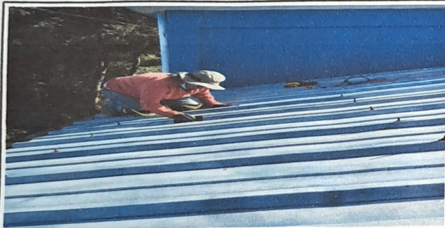
Foto 3: Mantenimiento a 60 m2 de techo de lámina con pintura anticorrosiva (incluye limpieza y lijado previo) en área de Cocina Escolar.
