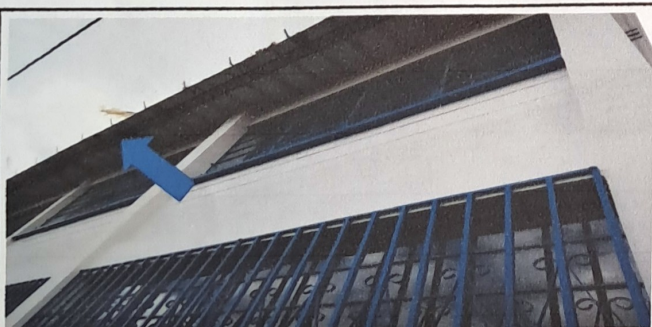
Foto 5: Sustitución de 14 mts. de Canal de Agua Pluvial de 3" y accesorios PVC en Modulo 1.
