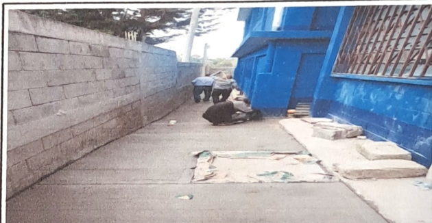
Foto 4: Reparacion de 110 m2 de plancha de concreto en pasillos posteriores de Módulo 1, módulo 3, area de cocina y area de servicios sanitarios.
