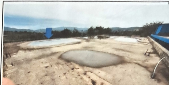
Foto 2: Sustitución de bajadas de agua pluvial con tubo de 2 1/2 en aulas de módulo 2
