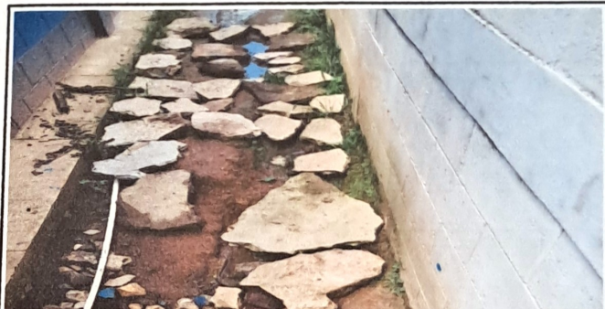
Foto 4: Reparación de plancha de concreto en pasillos posteriores de Módulo 1, módulo 3, área de cocina y área de servicios sanitarios
