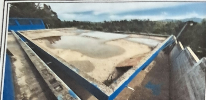
Foto 1: Mantenimiento correctivo de 198 m2 de losa con impermeabilizante acrílico de 6 años en aulas de módulo 2.
