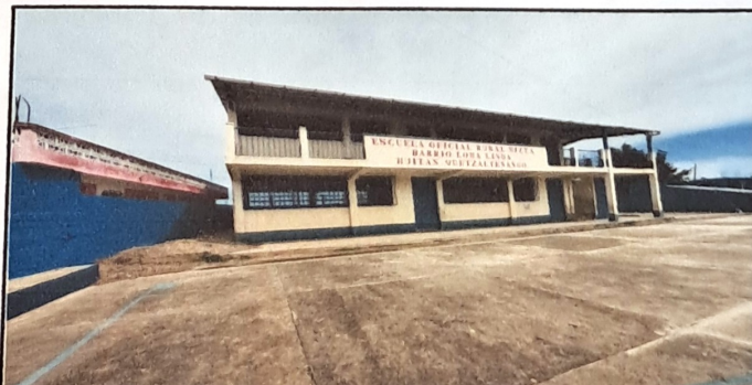
Foto 6: Suministro y aplicación de pintura exterior e interior, en Módulo 1, latex color blanco hueso ( incluye limpieza, resane mínimo y aplicación)
