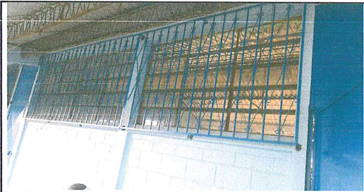
Foto 3: Mantenimiento a estructura de metal de 20 metros cuadrados de balcones (incluye lijado y pintado) en aulas de módulo 1 y 2
