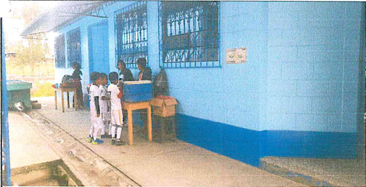
Foto 5: Suministro y aplicación pintura exterior de aceite a 37 metros cuadrados para zócalo, módulo 1 y 2 (incluye limpieza y resane)
