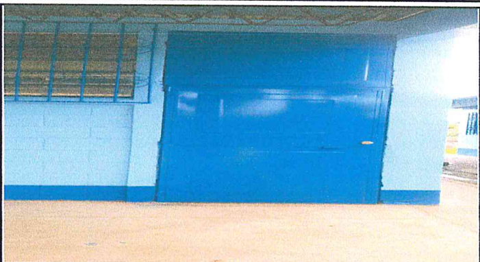
Foto 2: Mantenimiento a estructura de metal en 7 puertas de metal (incluye lijado, cambio de partes dañadas y pintado) en aulas de módulo 1 y 2 con pintura)
