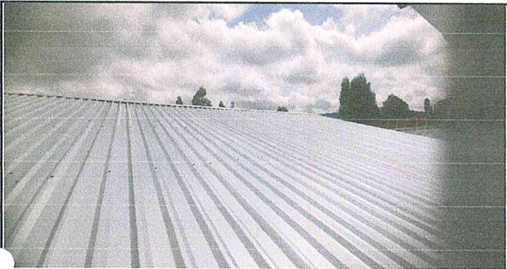
Foto1: Sustitución de 80 metros cuadrados de lámina por lámina troquelada 0.38 calibre 26" en aulas de módulo 1.
