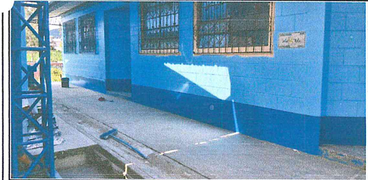
Foto 5: Suministro y aplicación pintura exterior de aceite a 37 metros cuadrados para zócalo, módulo 1 y 2 (incluye limpieza y resane)
