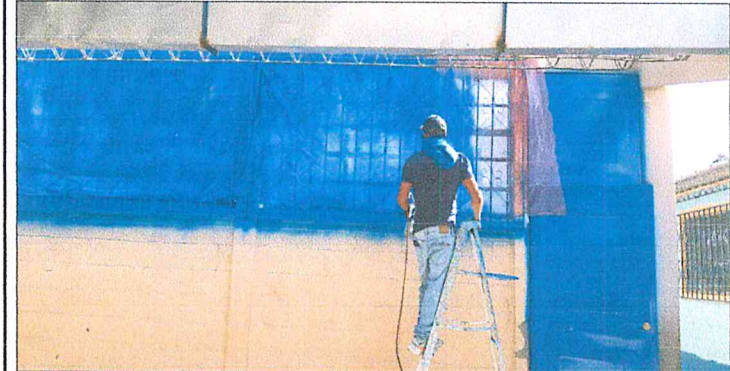
Foto 3: Mantenimiento a estructura de metal de 20 metros cuadrados de balcones (incluye lijado y pintado) en aulas de módulo 1 y 2
