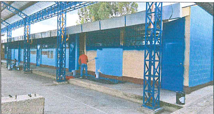
Foto 4: Suministro y aplicación de pintura exterior de 198 metros cuadrados en aulas de módulos 1 y 2 (limpieza, resane y aplicación)
