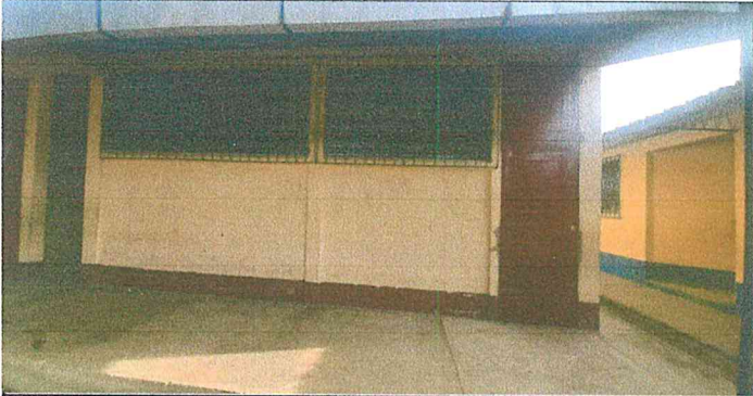
Mantenimiento a estructura de metal de balcones (incluye lijado y pintado) en aulas modulo 1 y 2
