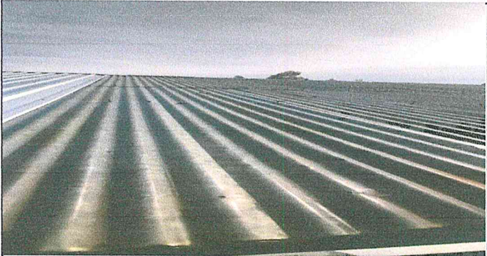
Sustitución de lámina por lámina troquelada 0.38 calibre 26" en aulas de modulo 1
