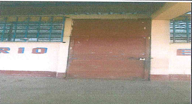
Mantenimiento en estructura de metal de puertas de metal (incluye lijado, cambio de partes dañadas y pintado) en aulas de módulo 1 y 2 con pintura
