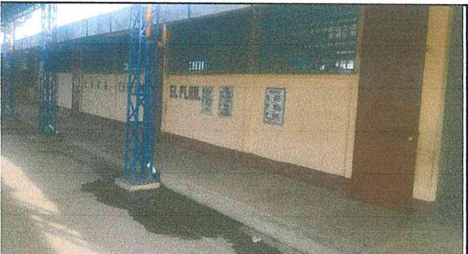
Suministro y aplicación de pintura exterior en aulas de módulos 1 y 2 (limpieza, resane y aplicación)
