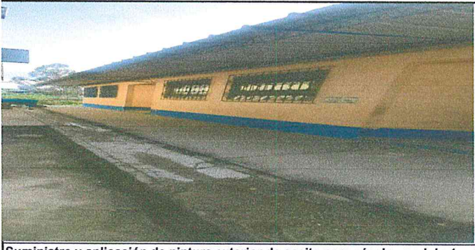
Suministro y aplicación de pintura exterior de aceite para zócalo, modulo 1 y 2, (incluye limpieza y resane)
