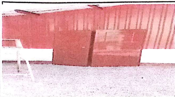
Foto 3: Sustitución de porton metálico de salón escolar en módulo 2
