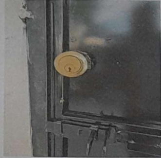
Foto 1: Reparación de 2 puertas e instalación de 2 chapas, por trabajos extras realizados, módulo 1
