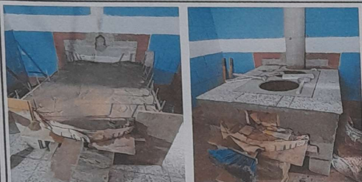
Foto 3: Sustitución de estufa con ladrillo y chimenea, módulo 1
