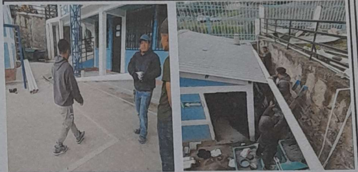
Foto 2: Sustitución de bajada de agua pluvial de la cocina escolar, por trabajos extras realizados, módulo 1
