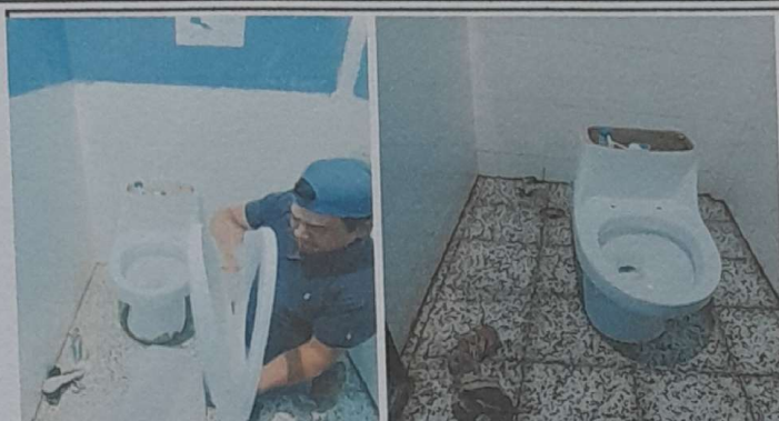
Foto 2: Sustitución de inodoros elongados, módulo 1
