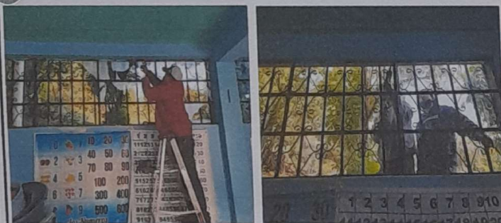
Foto 5: Sustitución e instalación de vidrios, aula cerca de la dirección y dirección, módulo 1
