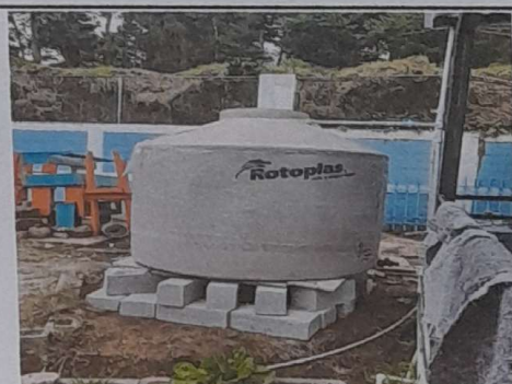
Foto 6: Sustitución de depósito de agua 2500 litros, modulo 1
