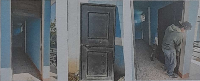
Foto1: Reparación de 2 puertas e instalación de 2 chapas, por trabajos extras realizados, módulo 1
