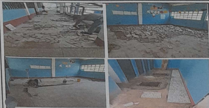
Foto1: Sustitución, demolición e instalación de piso granito en aulas y baños, módulo 1
