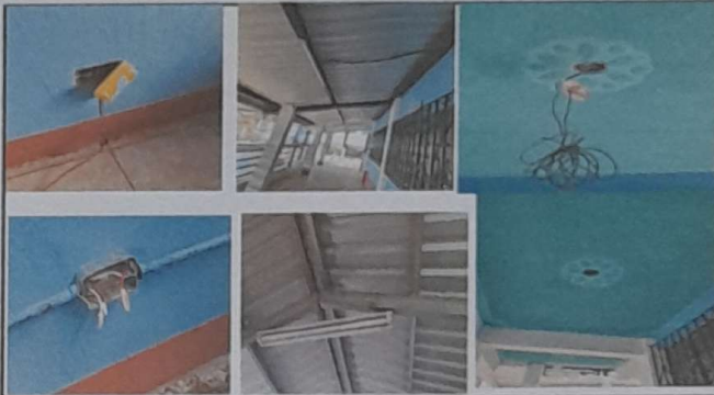
Mantenimiento de sistema eléctrico en 3 aulas 2do nivel, corredor, dirección, cocina y demás aulas, módulo 1
