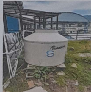
Sustitución de depósito de agua 2500 lts, módulo 1
