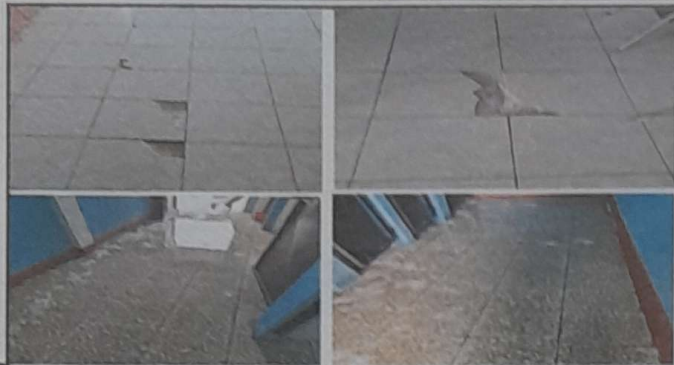
Sustitución de piso cerámico por piso de granito en baños y aulas módulo 1
