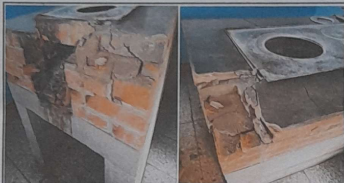
Sustitución de estufa en cocina con ladrillo y chimenea, módulo 1
