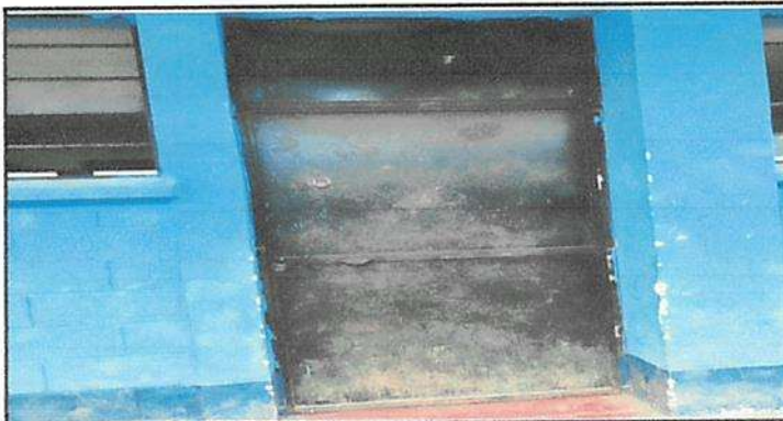
Sustitución de puerta metálica en aulas de Modulo 1 y 2
