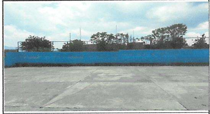
Suministro y aplicación de pintura para exterior latex celeste pantone 293 en muros en muros area recreativa, modulo 1, 2 y 3.
