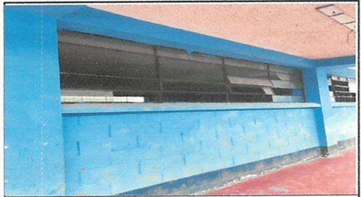
Sustitución de estructura de metal de ventana de aulas modulo 1, 2 y 3. Fabricación e instalación de balcones de seguridad con tubo cuadrado de 1" chapa 18 + perfil hembra de 1" x 1/8" (va en renglon 2)
