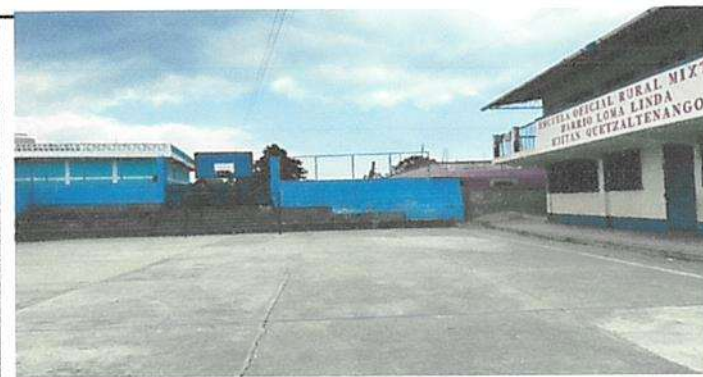
Suministro y aplicación de pintura para exterior de hule azul pantone 289 en zocalos de muros area recreativa, modulo 1, 2 y 3.
