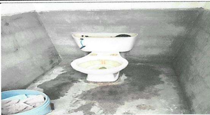
Sustitución de 2 inodoros elongados en baños
