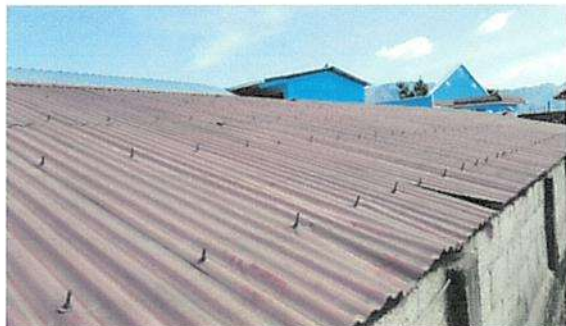
Sustitución de lamina canalada por lamina troquelada calibre 26
