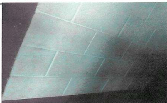
Suministro y aplicación de pintura en el interior de las aulas
