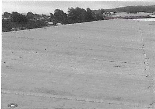
Sustitución de lámina por lámina troquelada 0.38 Calibre 26" en módulo 1 y 2
