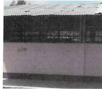
Sustitución de lámina por lámina troquelada 0.38 Calibre 26" en módulo 1 y 2
