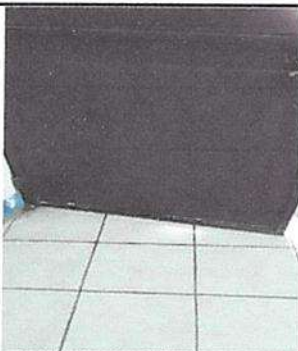
Sustitución de 2 puertas metálicas para aulas
