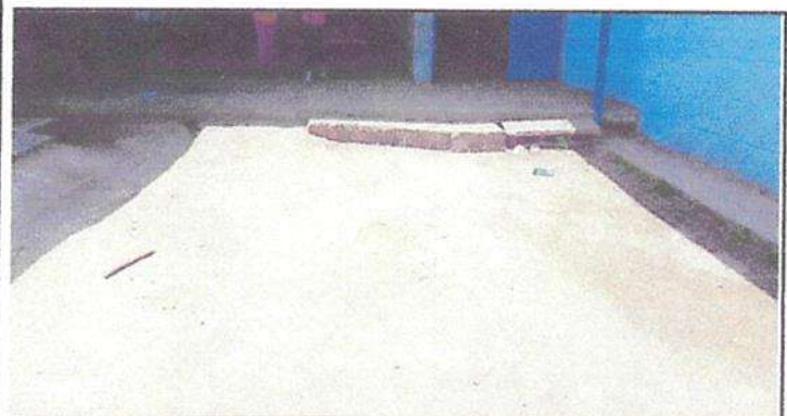
Mantenimiento piso de torta de concreto de 10cm+base10cm, compactación y nivelación en área recreativa,
