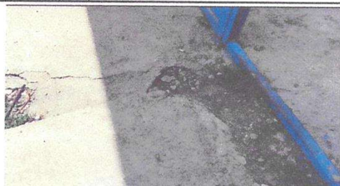
Mantenimiento piso de torta de concreto de 10cm+base10cm, compactación y nivelación en área recreativa,
