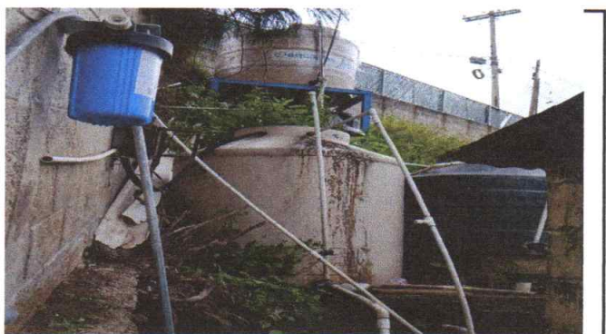
Reparación de bomba de agua modulo 4
