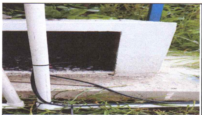
Sustitución de cableado eléctrico modulo 4 (Después)
