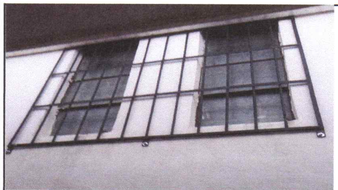
Sustitución de balcones modulo 3 (Después)
