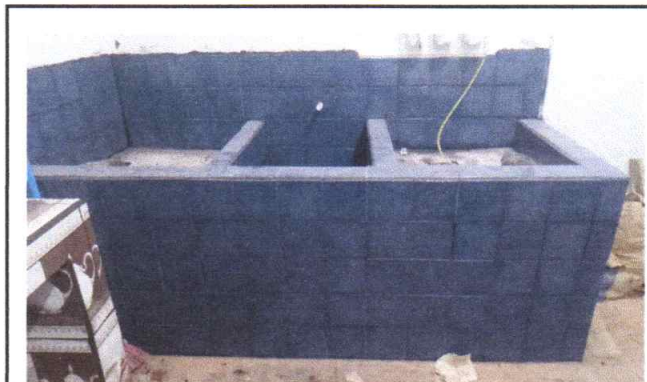
Sustitución de azulejo, cocina, pila modulo 2 (posterior)
