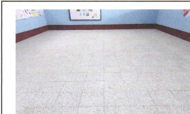
sustitución de piso de torta de concreto a granito, en alula modulo 4 (posterior)
