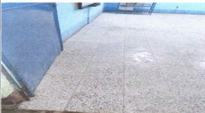
Sustitución de piso de torta de concreto a granito en aula, modulo 1 (Posterior)
