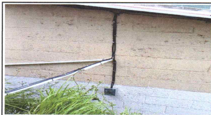
Sustitución de flipones modulo 4 (Después)
