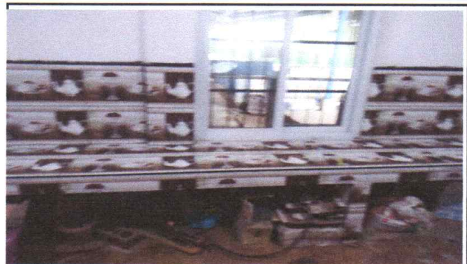
Reparación mesas de trabajo de cocina modulo 2 (Después)
