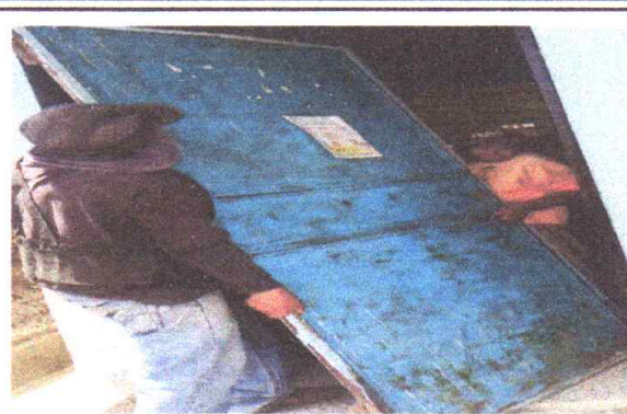
Sustitución de puerta metalica en aula modulo 4 (Durante)
