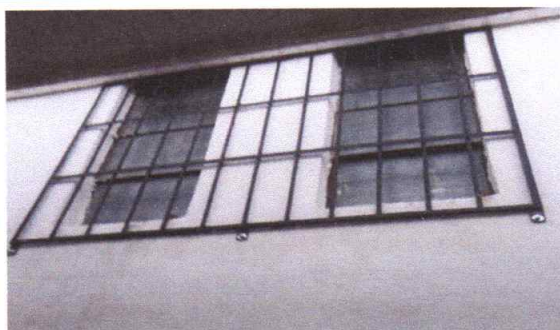
Sustitución de balcones modulo 3
