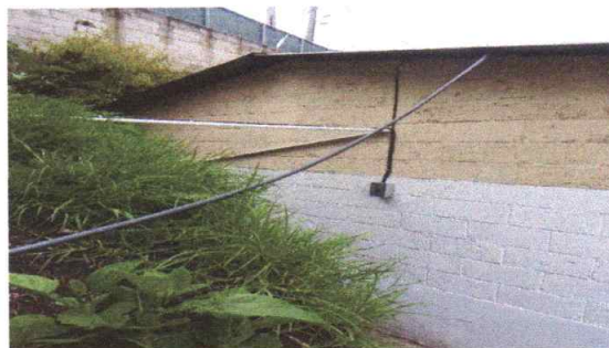
Sustitución de cableado eléctrico modulo 4
