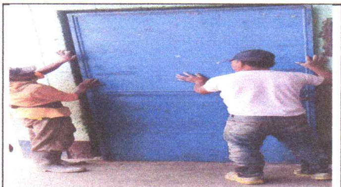
Sustitución de puerta metalica en aula modulo 1 (durante)
