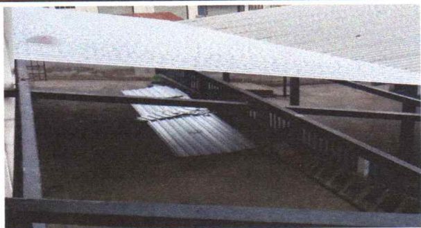
Sustitución de lámina por lamina troquelada modulo 2 (Durante)
