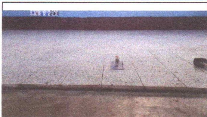
sustitución de piso de torta de concreto a granito, en aula modulo 4 (Durante)
