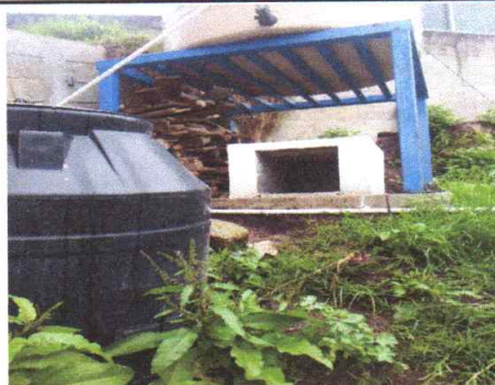
Reparación de bomba de agua modulo 4 (durante)
