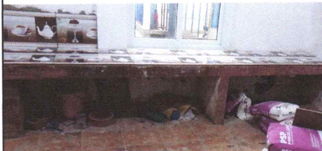
Reparación mesas de trabajo de cocina modulo 2 (Durante)
