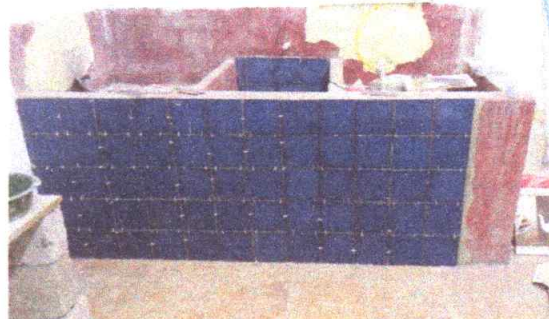
Sustitución de azulejo, cocina, pila modulo 2 (durante)
