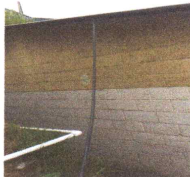
Sustitución de cableado eléctrico modulo 4
