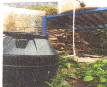
Reparación de bomba de agua modulo 4
