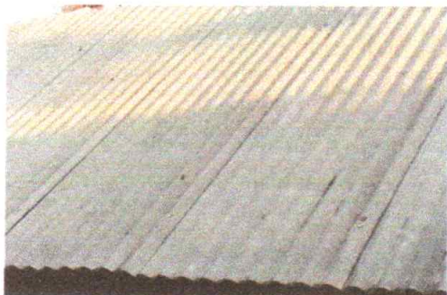
Sustitución de lámina por lamina troquelada modulo 2
