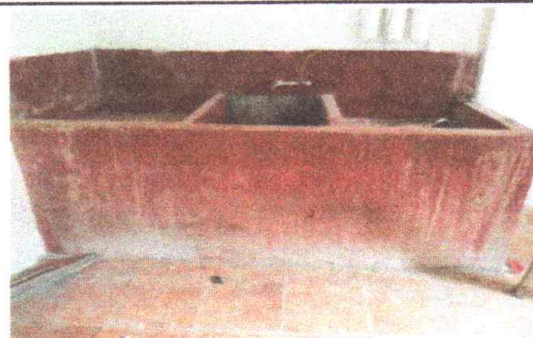
Sustitución de azulejo, cocina, pila modulo 2
