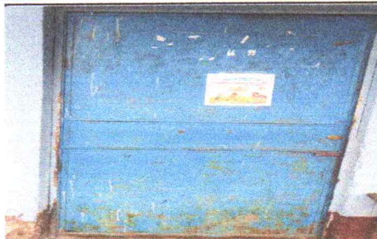
Sustitución de puerta metálica en aula modulo 1 y modulo 4
