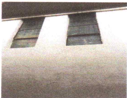
Sustitución de balcones modulo 3
