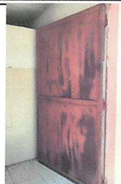
BAÑOS: Mantenimiento de puerta metálica.
