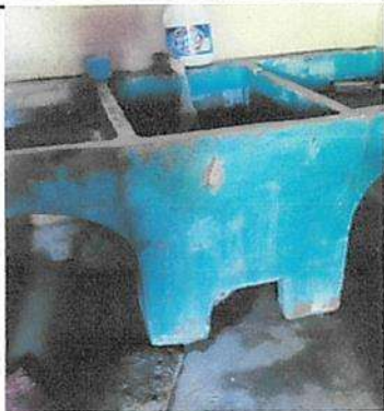
Sustitución de base de concreto para pila de pila prefabricada de dos alas de drenaje de 3"
