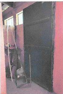
BODEGA: Mantenimiento de puerta metálica
