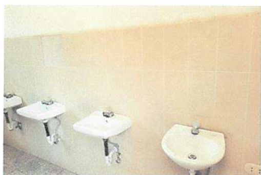
BAÑOS: Sustitución de lavamanos a lavamanos de concreto fundido con seis chorros.
