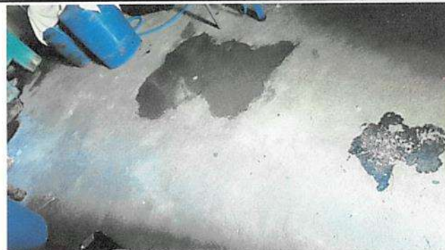
COCINA: Sustitución de piso de concreto a piso cerámico. Sustitución de reposadera de aluminio
