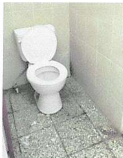
BAÑOS: Sustitución de tubería de agua potable de 1/2"
