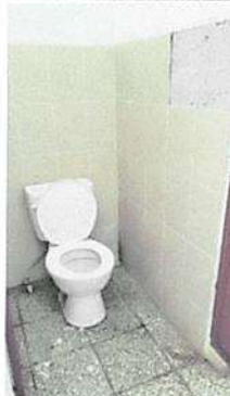
BAÑOS: Sustitución de kit de tanque de inodoro
