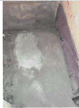
BODEGA: Sustitución de piso de concreto a piso cerámico.
