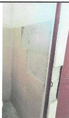
BAÑOS: Sustitución de azulejo
