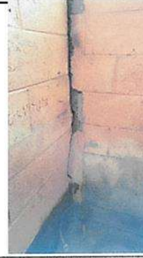
BODEGA: Reparación de muro con repello Aplicación de pintura látex
