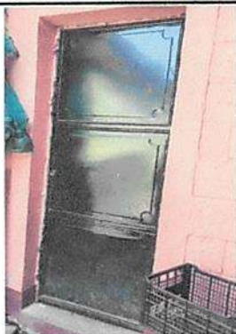
COCINA: Mantenimiento de puerta metálica
