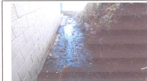
Mantenimiento de banqueta de concreto
