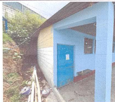
Mantenimiento correctivo de cuneta con reja
