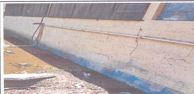
Suministro y aplicación de impermeabilizante en muro de block del aula existente
