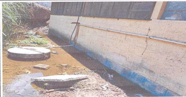
Mantenimiento correctivo de pasillo trasero de aula para acceso a pozo
