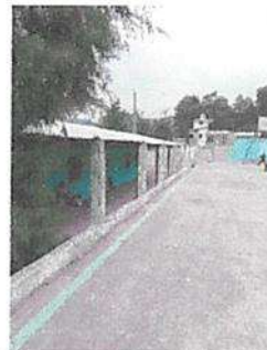
Mantenimiento y sustitución de malla metálica por celosía
