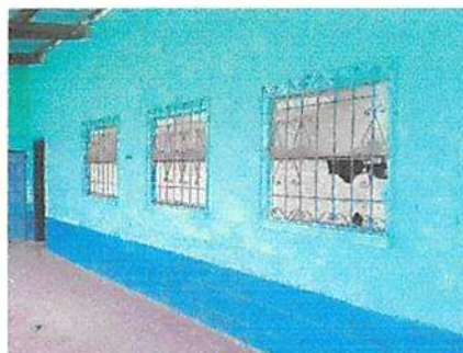
Mantenimiento y sustitución de vidrios en ventanas
