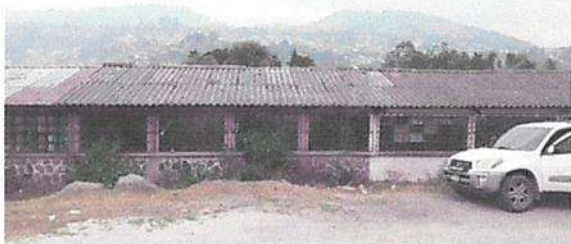
Mantenimiento, sustitución de lámina por lámina troquelada calibre 26
