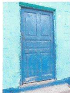
Mantenimiento sustitución de puertas de madera por metálicas
