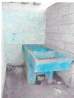
Mantenimiento y reparación de baño para docentes
