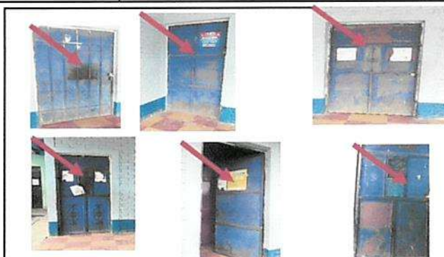
Mantenimiento de seis puerta de metal (lijado, pintado, y cambio de partes de perfiles dañados)
