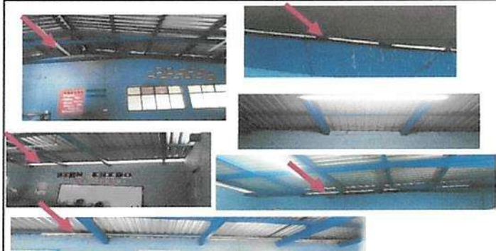
Suministro Y mano de obra de concreto para recubrir separación entre lamina y pared existente
