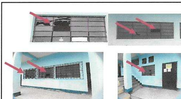
Sustitución de vidrios de ventanas de tres aulas de 5 mm
