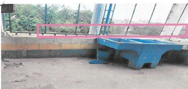
Sustitución de pila de cemento con lavamanos azulejada de 3.20 de largo x 70 de fondo de 6 chorros
