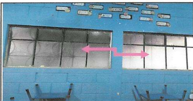
Sustitución de dos ventanas de vidrio nevado a vidrio transparente de 5 mm en un aula
