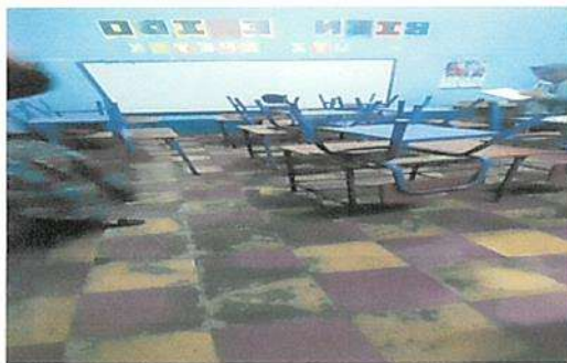
Sustitución de piso de granito a piso ceramico de 6.30 x 8.80
