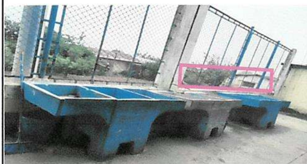
Sustitución de pila de cemento con lavadero de 3 aletas y dos fosas de agua azulejada de 2.10 x 55 con 2 chorros
