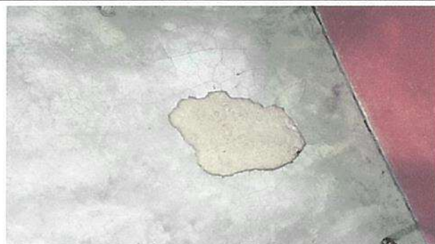
Suministro e instalacion de piso ceramico en aula modulo 7
