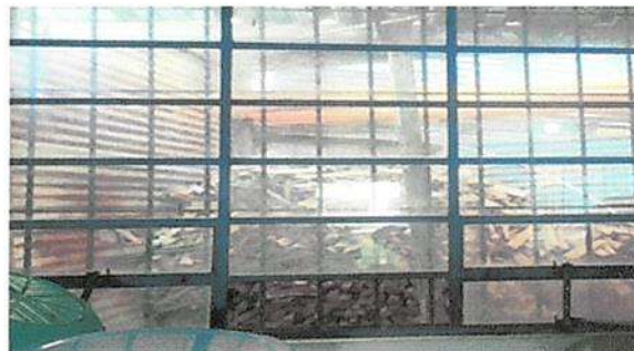
Suministro e instalacion de ventanas con pvc en aula modulo 7
