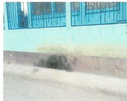
Suministro de pintura latex en exterior de edificio de establecimiento modulo 2,3,4,5 y 6
