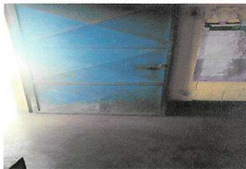
Remozamiento de puerta en aula modulo 7
