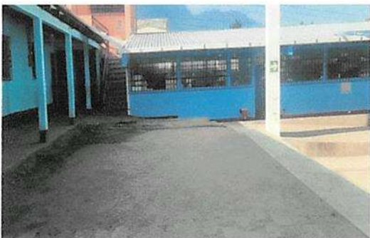
Suministro de pintura latex en exterior de edificio de establecimiento modulo 2,3,4,5 y 6
