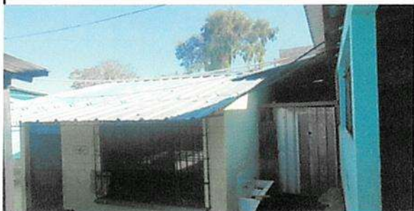
Remozamiento de balcones en aula, modulo 7
