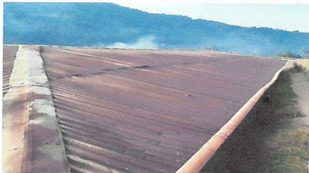
Sustitución de canal y bajada de agua pluvial metros lineales
