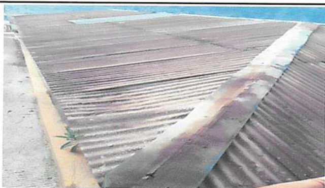
Sustitución de capote calibre 26 metros lineales
