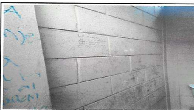
Suministro y aplicación de pintura de pared de servicios sanitarios
