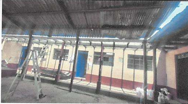
Suministro y aplicación de pintura a Estructura Metálica
