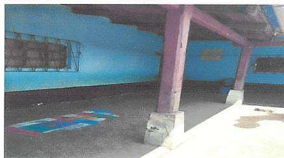
Sustitución de portantes de madera
