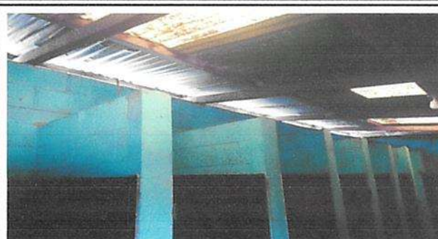
Sustitución de estructura portante de metal
