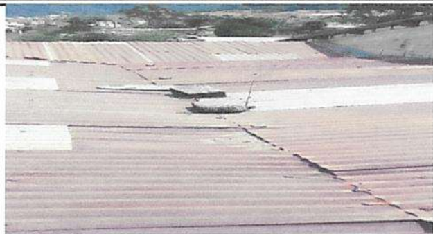
Sustitución de Láminas baños
