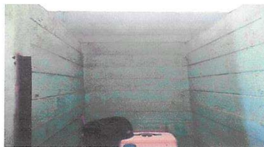
Mantenimiento de paredes baños (pintura)
