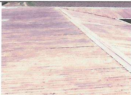
Sustitución de láminas acanaladas modulo 4
