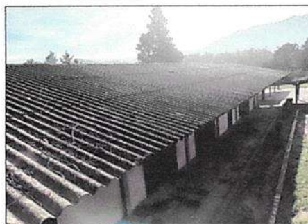
Suministro de cubierta de lámina troquelada MAXALUM C26
