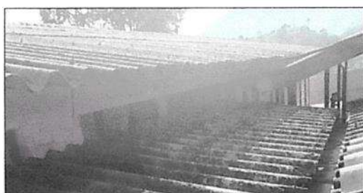
Suministro de cubierta de lámina troquelada MAXALUM C26
