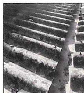
Suministro de cubierta de lámina troquelada MAXALUM C26
