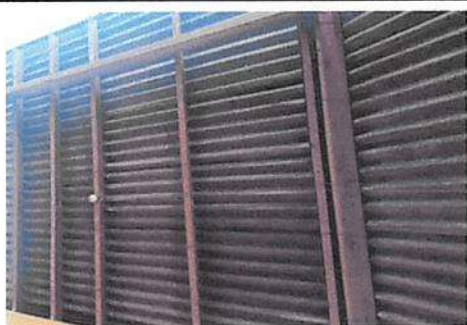
Suministro de cubierta de lámina troquelada MAXALUM C26
