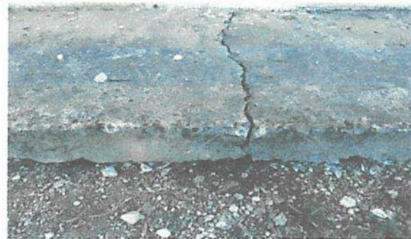
Reparación de banqueta de concreto
