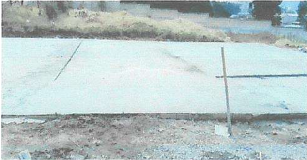
Reparación de plancha de concreto de patio
