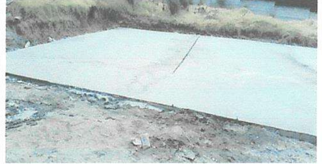
Reparación de planchas de concreto de patio
