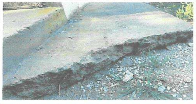
Reparación de banqueta de concreto
