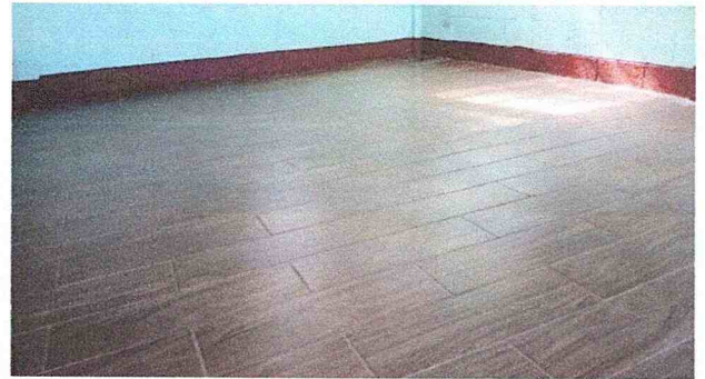
Foto 4: Culminacion total de piso.
