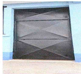
Foto 6: Acabado total de pintura de puertas
