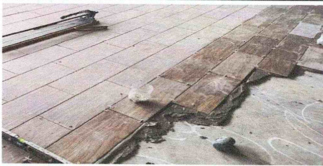
Foto1: Area de sustitucion de piso
