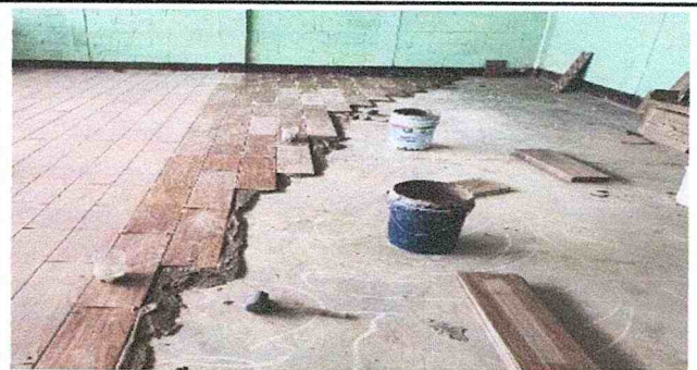
Foto 2: Avance del trabajo de sustitucion de piso
