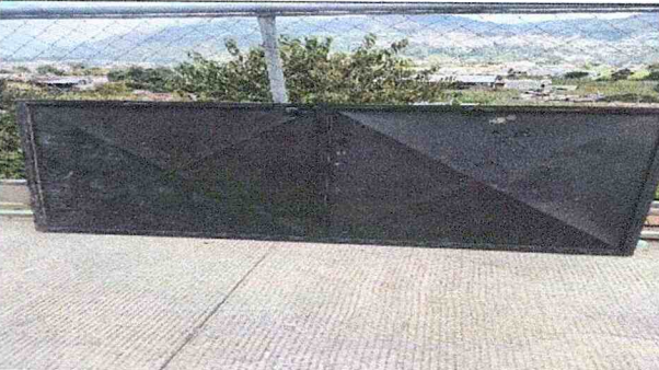
Foto 5: Limpieza y lijado de puerta para el matenimiento
