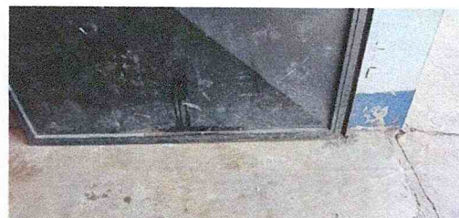
Mantenimiento de puertas metálicas (lijado, pintura) módulo 1
