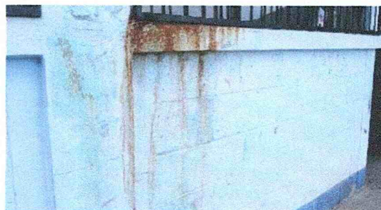
Suministro y aplicación de pintura exterior celeste pantone 293 y zócalo azul pantone 293 módulo 1
