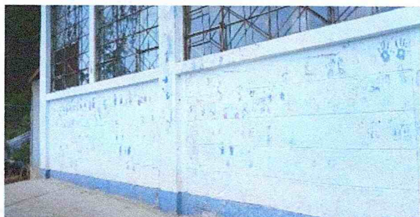
Suministro y aplicación de pintura exterior celeste pantone 293 y zócalo azul pantone 293 módulo 1
