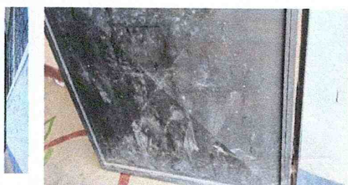
Mantenimiento de puertas metálicas (lijado, pintura) módulo 1
