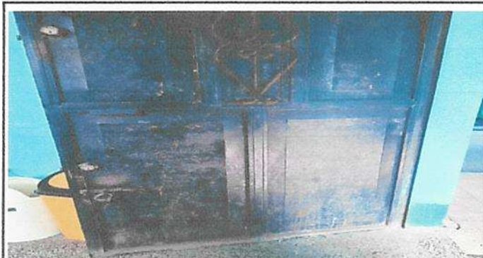
Mantenimiento de puertas
