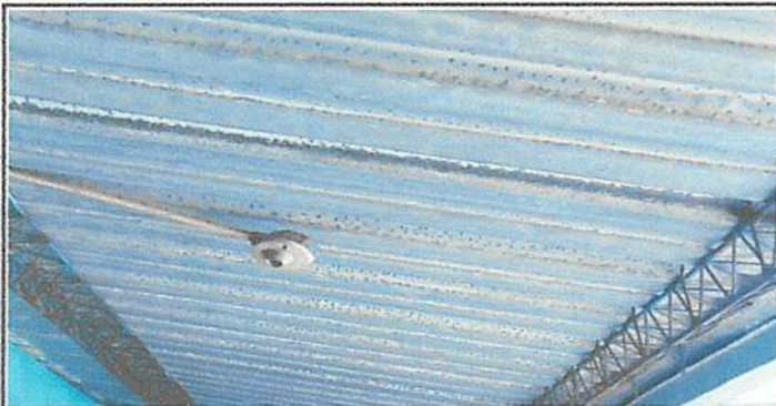
Sustitución de techo de corredor
