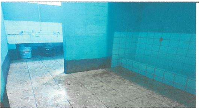
Mantenimiento de sanitario
