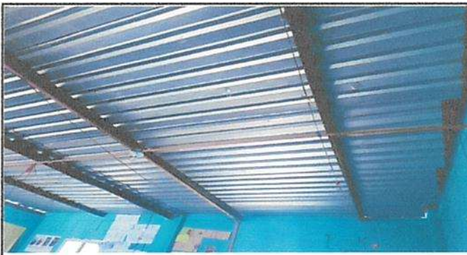
Mantenimiento de techo de aula modulo 2
