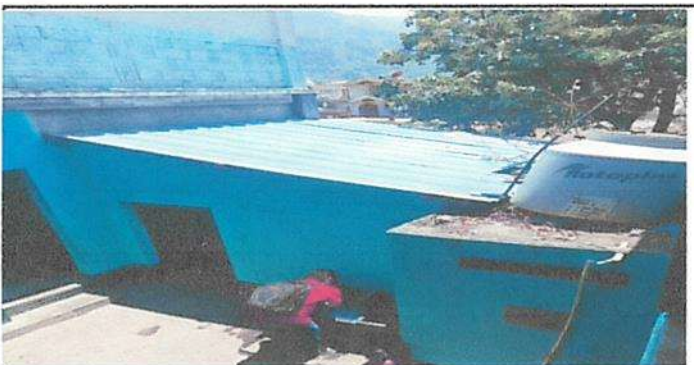
Sustitución de techo de bodega
