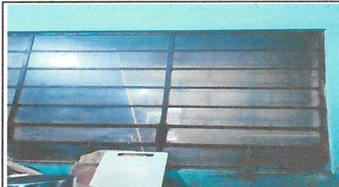
Sustitución de ventanas
