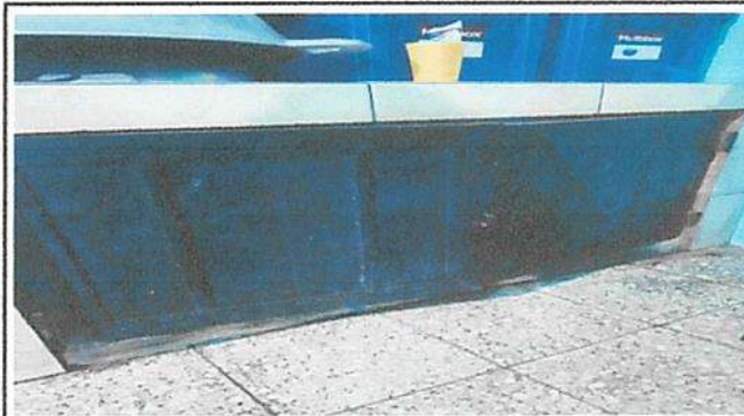
Mantenimiento de puerta gabinete
