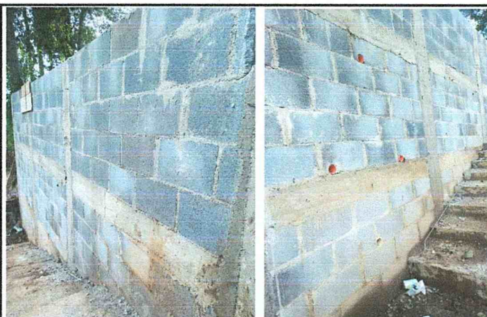
Foto 3: Muro de contección #3
