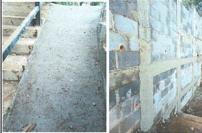
Foto 2: Sustitución muro de contección #2
