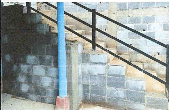
Foto 1: Muro de cotección #1
