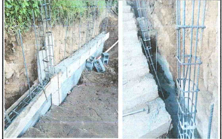
Foto 2: Sustitución muro de contección #2
