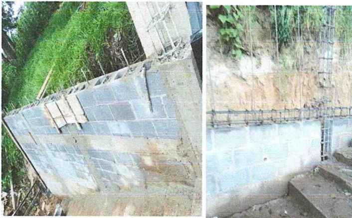
Foto 3: Muro de contección #3
