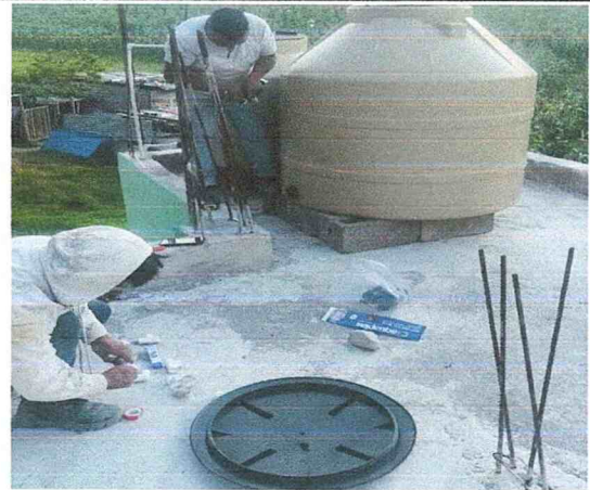
Foto 4: Sustitución deposito de agua 1,000 litros
