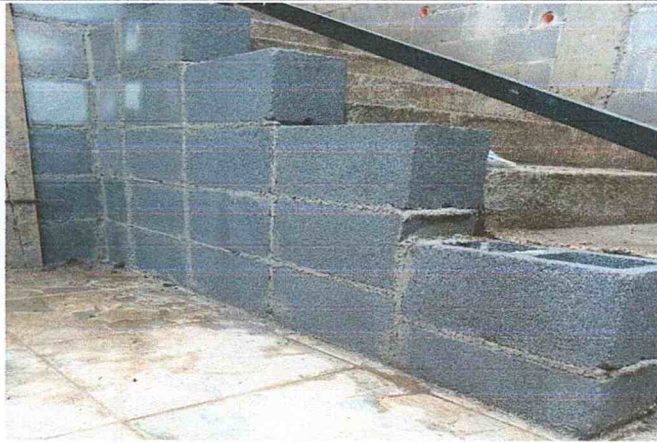
Foto 1: Muro de contección #1
