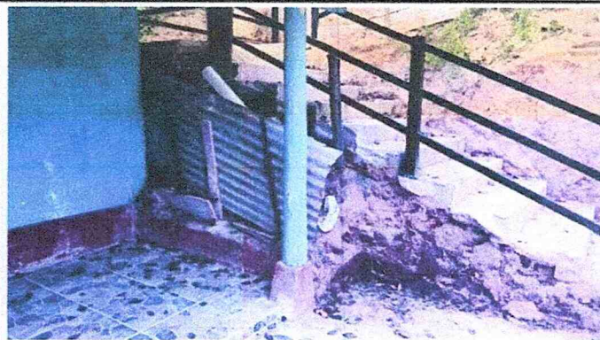
Sustitución Muro de contención # 1
