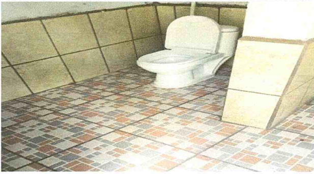
Foto1: finalizacion sustitución de inodoro tipo baby
