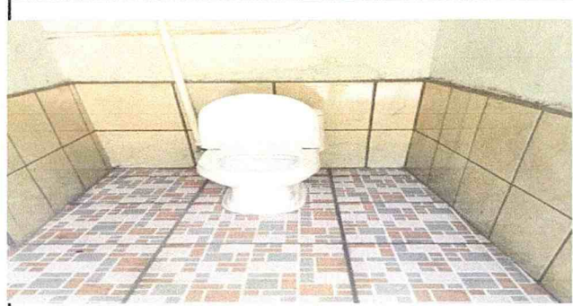
Foto 2: Finalización sustitución de azulejos en baño
