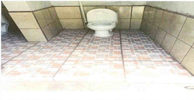
Foto 3: Finalización sustitución de piso en baño
