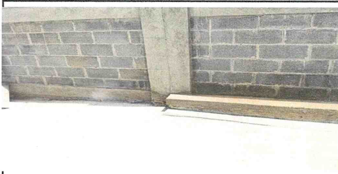
Foto 5: Finalización sustitución de piso de torta de concreto
