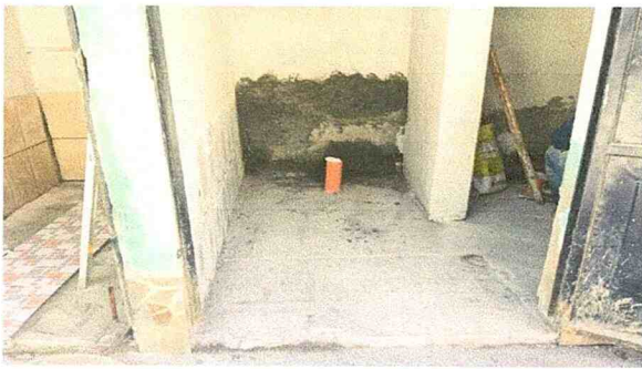
Foto1: Sustrucción de inodoro tipo baby
