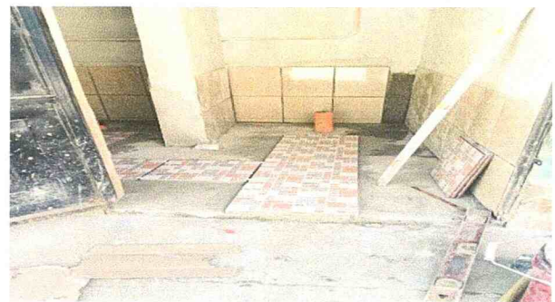
Foto 2: Sustrucción de azulejos en baño
