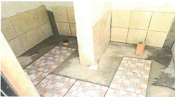
Foto 3: Sustrucción de piso en baño
