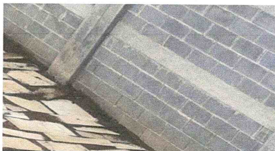
Sustitución de piso de torta de concreto
