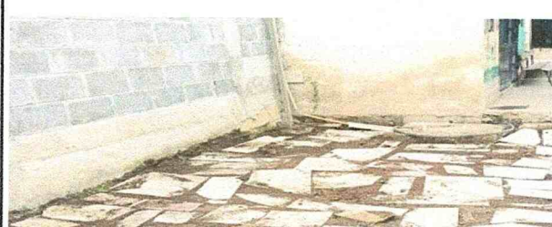
Sustitución de piso de torta de concreto
