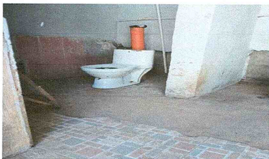
Sustitución de inodoro tipo baby
