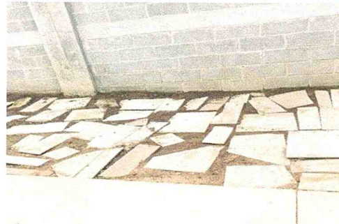
Sustitución de piso de torta de concreto
