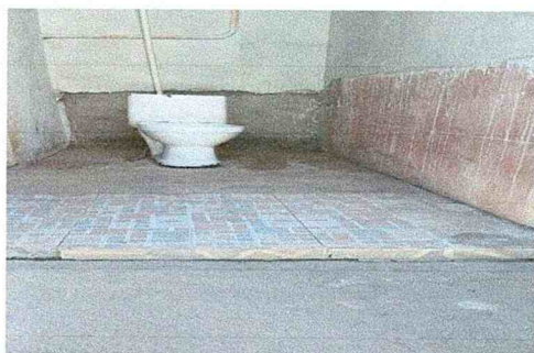
Sustitución de piso en baño
