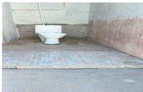
Sustitución de azulejos en baño
