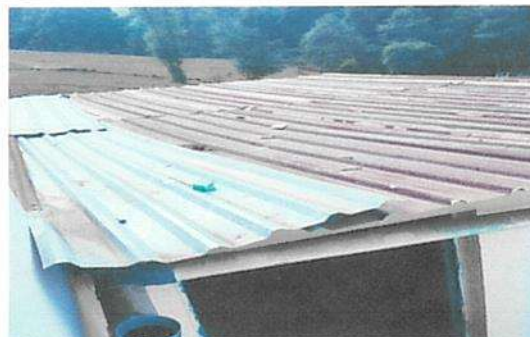
Sustitución de lámina por lámina troquelada calibre 26
