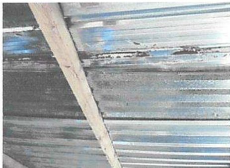
Sustitución de estructura de soporte de metal
