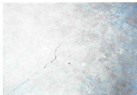
Sustitución de piso por piso cerámico
