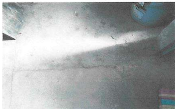
Sustitución de piso por piso cerámico
