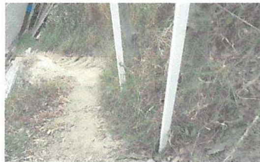
Suministro y sustitución de barandas
