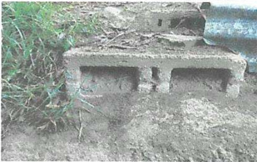
Suministro y Reparación de gradas
