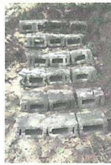
Suministro y Reparación de gradas
