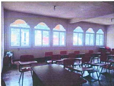
Sustitución de estructura de metal de ventana a pvc de 1.20 m2 cada ventana tercer nivel
