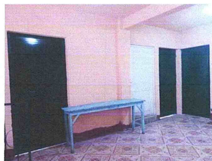
Sustitución de puertas tercer nivel
