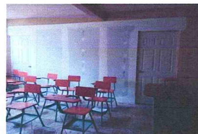
Mantenimiento correctivo en pared con division de tabla yeso y puerta, tercer nivel
