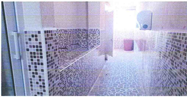
Mantenimiento correctivo con azulejo en pared y lavamanos tercer nivel
