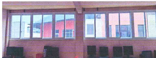
Sustitución de estructura de metal de ventana a PVC rectangular 4.32 m2 tercer nivel.
