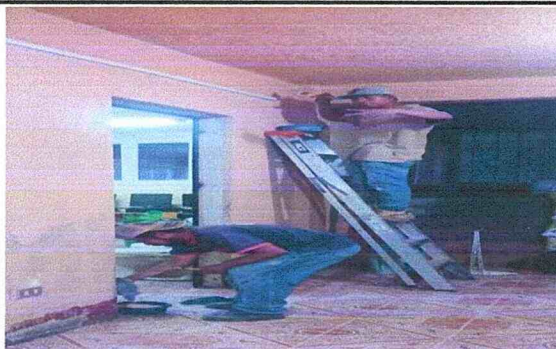
Suministro y aplicación de pintura en el pasillo, tercer nivel
