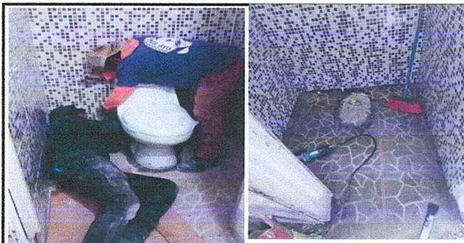
Sustitucion de inodoro alargado en baños del tercer nivel
