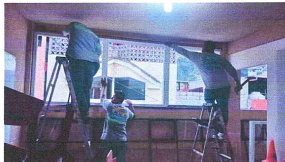
Sustitución de estructura de metal de ventana a PVC rectangular 4.32 m2 tercer nivel.
