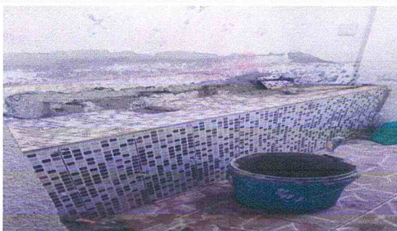
Mantenimiento correctivo en pared y lavamanos con azulejo, tercer nivel
