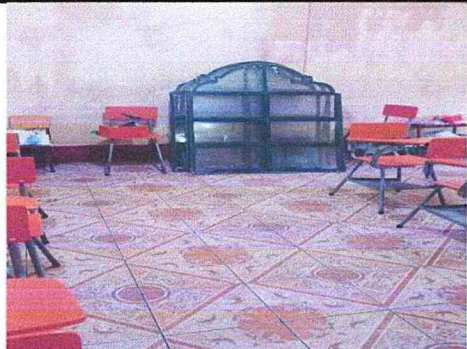
Sustitución de estructura de metal de ventana a pvc 1.20 m2 cada ventana, tercer nivel
