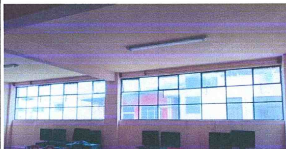
Sustitución de estructura de metal de ventana a PVC rectangular 4.32 m2 tercer nivel.
